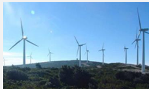
Parc éolien de TUCHAN Département : Aude (11) Puissance électrique : 11,7MW 18 éoliennes Mise en service : 2001 – 2002 – 2009
